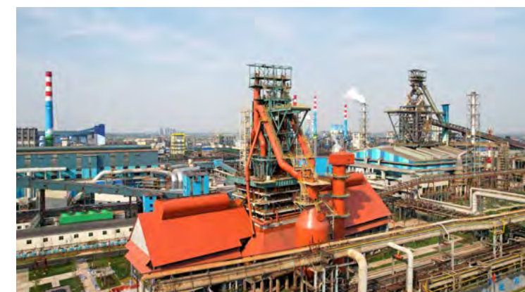
武钢有限一号炉照片
