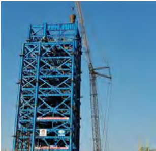
竖炉本体炉壳第一吊
