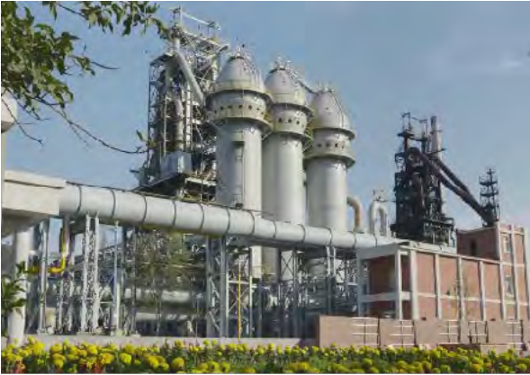
富氢碳循环氧气高炉
