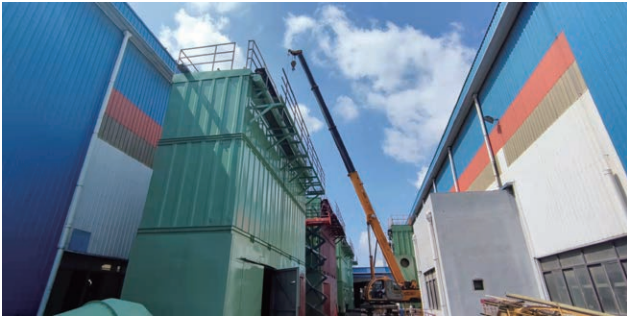
涂装线油改水施工现场
